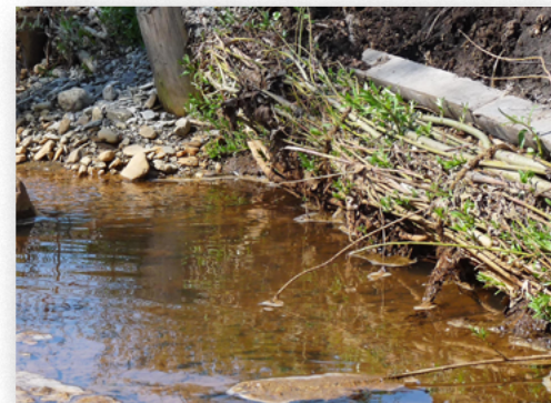
Die Weidenwalzen werden im nächsten Frühling austreiben.
