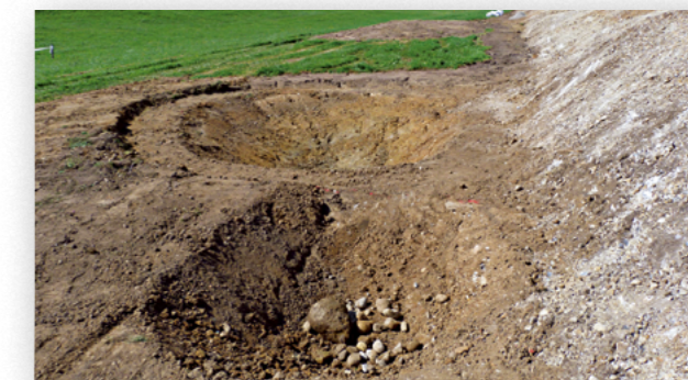
Mit dem Freilegen der Nagelfluhböschung und mit dem Aushub für Weiher und Steinlinsen startete die Umsetzung
