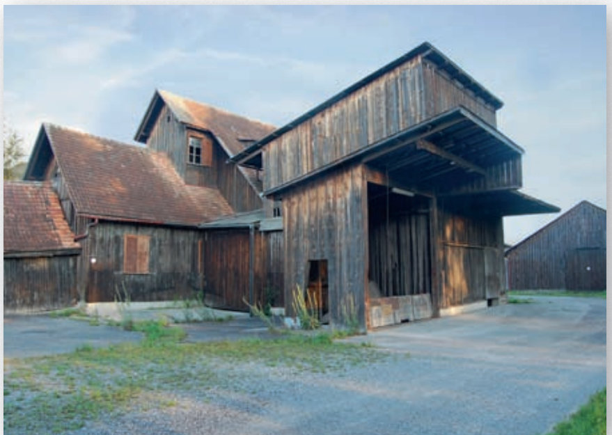
Die Kerngebäude bleiben erhalten.
