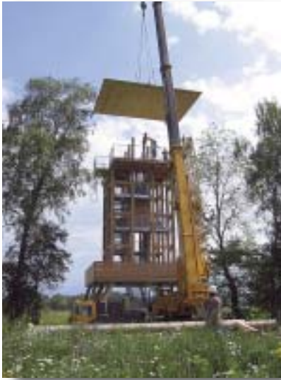
Das Dach wird aufgesetzt.
