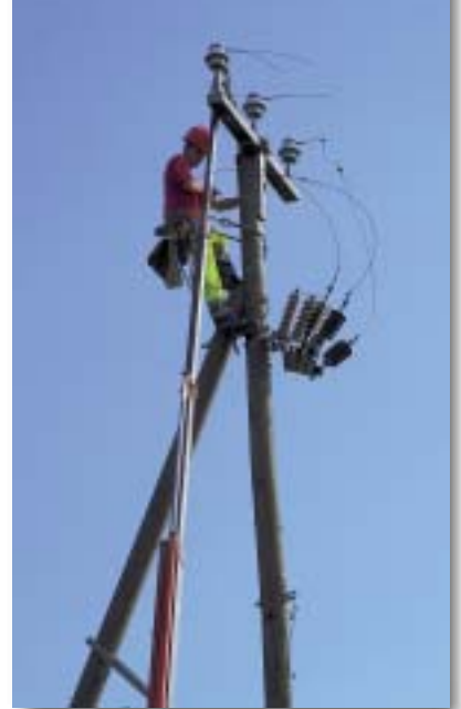
Handarbeit beim Demontieren der Freileitungen.
