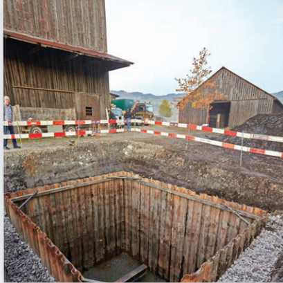
Das Fundament ist gerichtet
