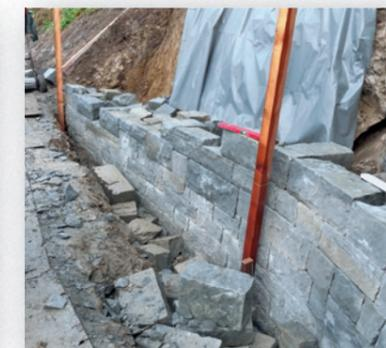
Bau einer Trockenmauer: gleichzeitig Stützfunktion und Lebensraumelement
