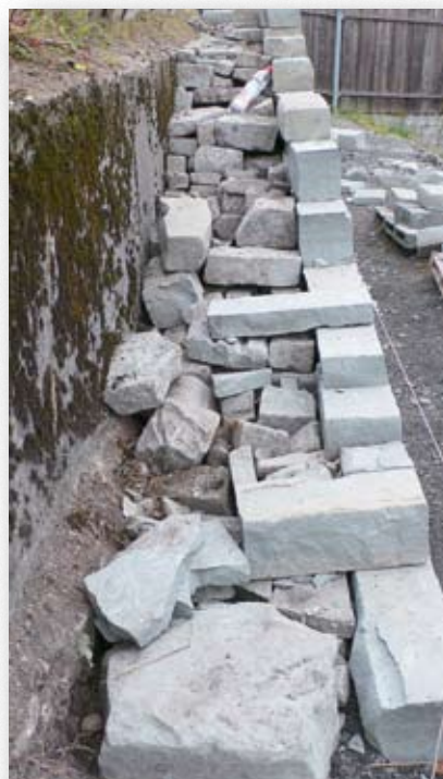
Innenleben einer Trockenmauer.
