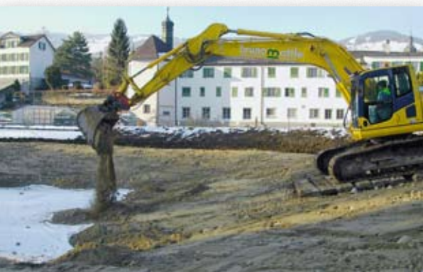
Die künftige Weihersohle wird eingebracht.
