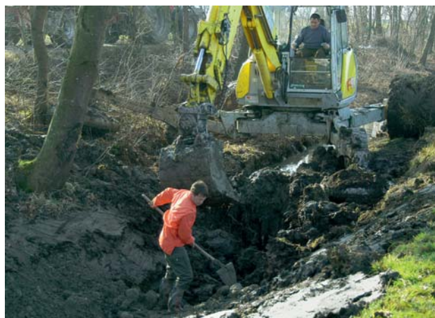
Gestaltung der neuen Bachsohle.
