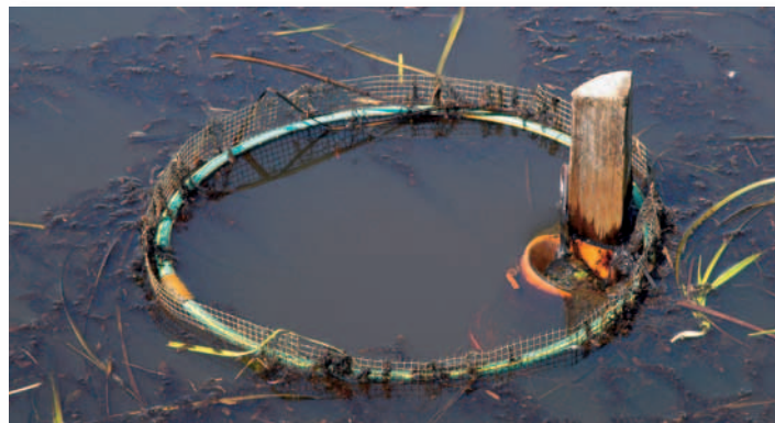
Der Überlauf muss von Geschwemmsel freigehalten werden.
